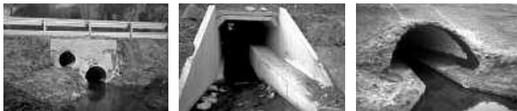
Exemples d'ouvrages, de diverses tailles, aménagés pour le passage de la loutre et de la "petite faune"
